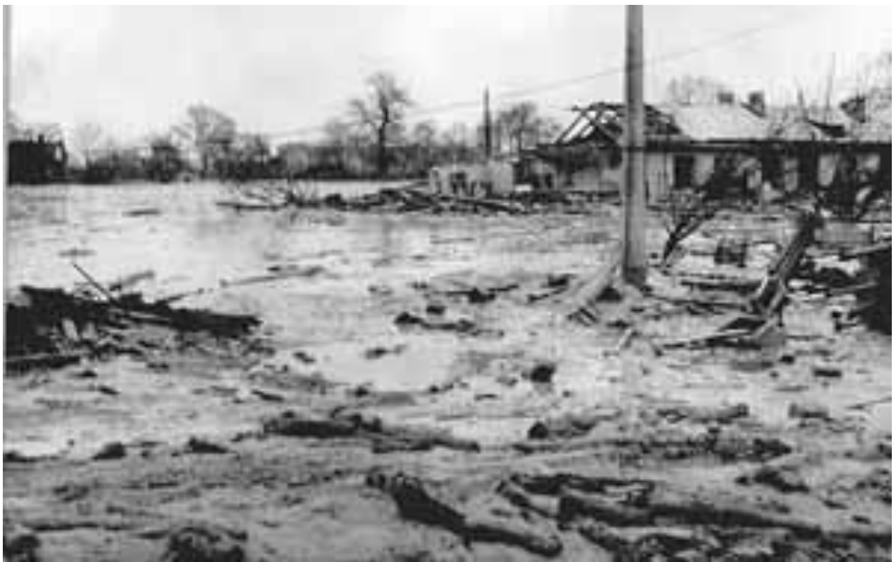
Вулиця Кирилівська (Фрунзе) з боку міста, залита розрідженою масою ґрунту
