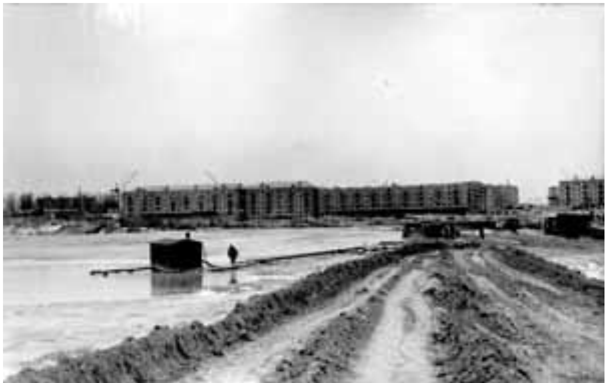
Фото намиву № 4 на ділянці № 3, де проводився намив. Зліва видно насосна станція для перекачки освітленої води
