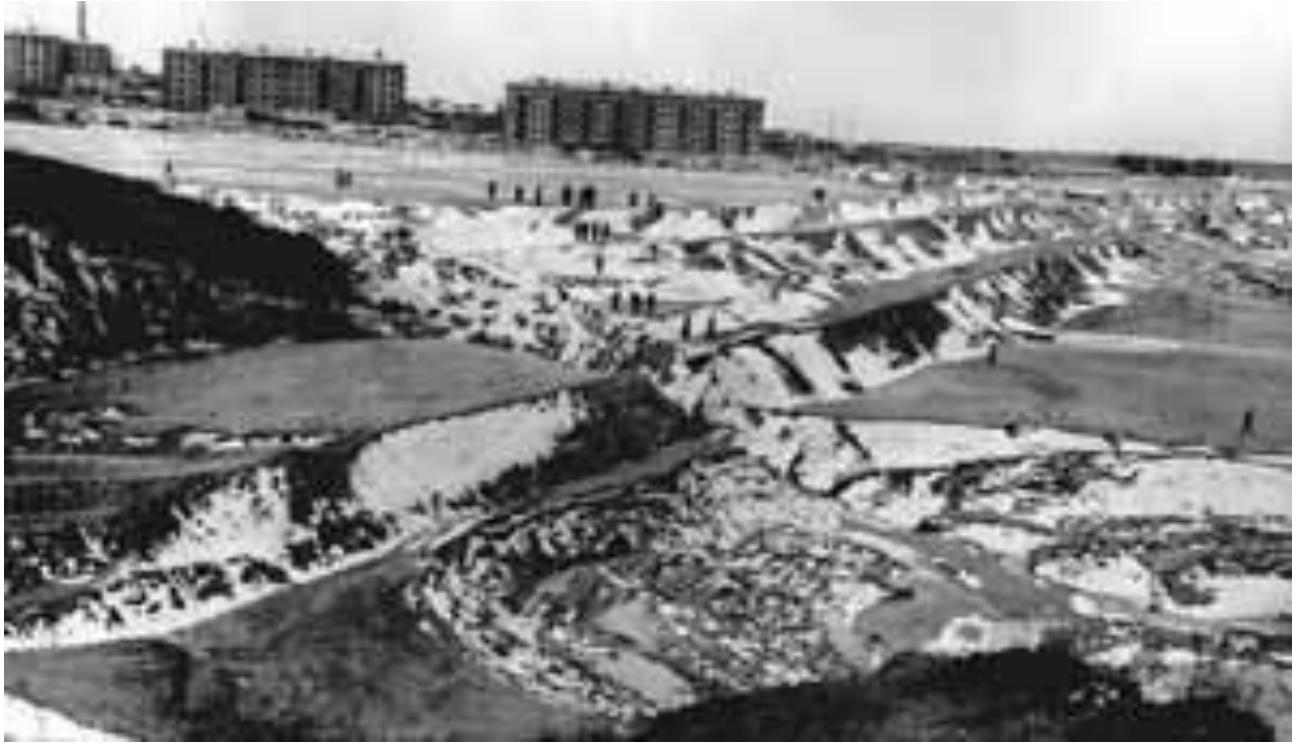
Загальний вигляд гідровідвалу. Зліва видно вимоїна в дамбі № 3. На передньому плані - верхня частина області виносу ґрунту з другого ділянки гідровідвалу
