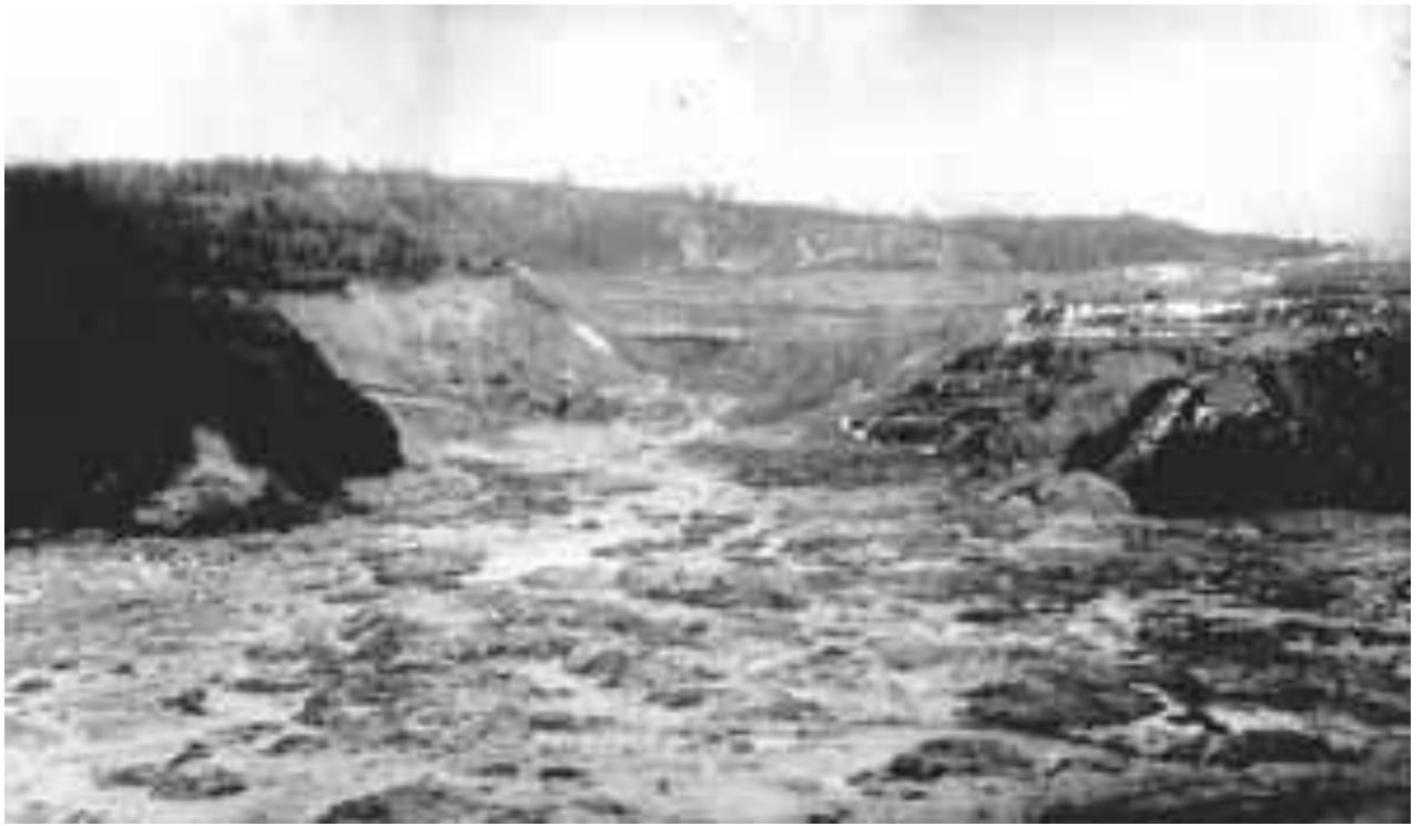
Вид на зруйнований гідровідвал у відрозі № 3 з боку міста. Праворуч – уціліла частина дамби № 1, ліворуч – завалена частина правого берега. На передньому плані залишки ґрунтової маси, що витекла за межі гідровідвалу
