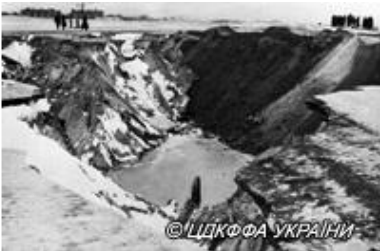
Права частина промोїни на ділянці №3 та дамби №3 біля правого берега третього відрогу Бабиного Яру після аварії. Київ, березень 1961 р.
