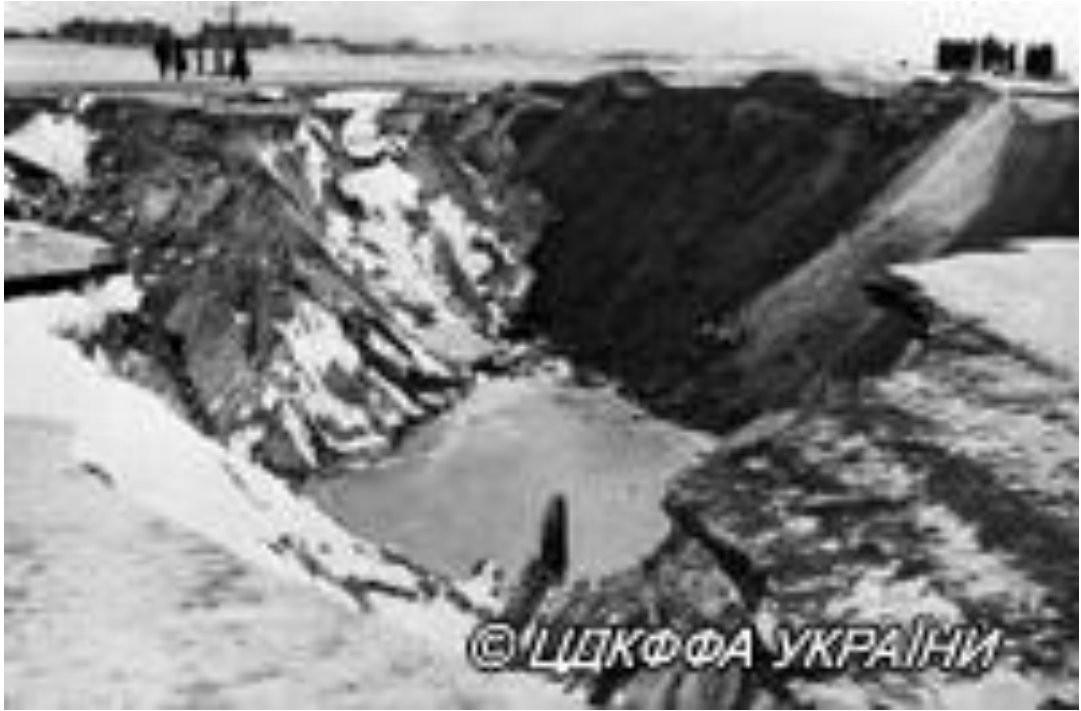
Права частина промоїни на ділянці №3 та дамби №3 біля правого берега третього відрігу Бабиного Яру після аварії. Київ, березень 1961 р. (Джерело: ЦДКФФА України ім. Г.С. Пшеничного, од. обл. 0-232385 )
