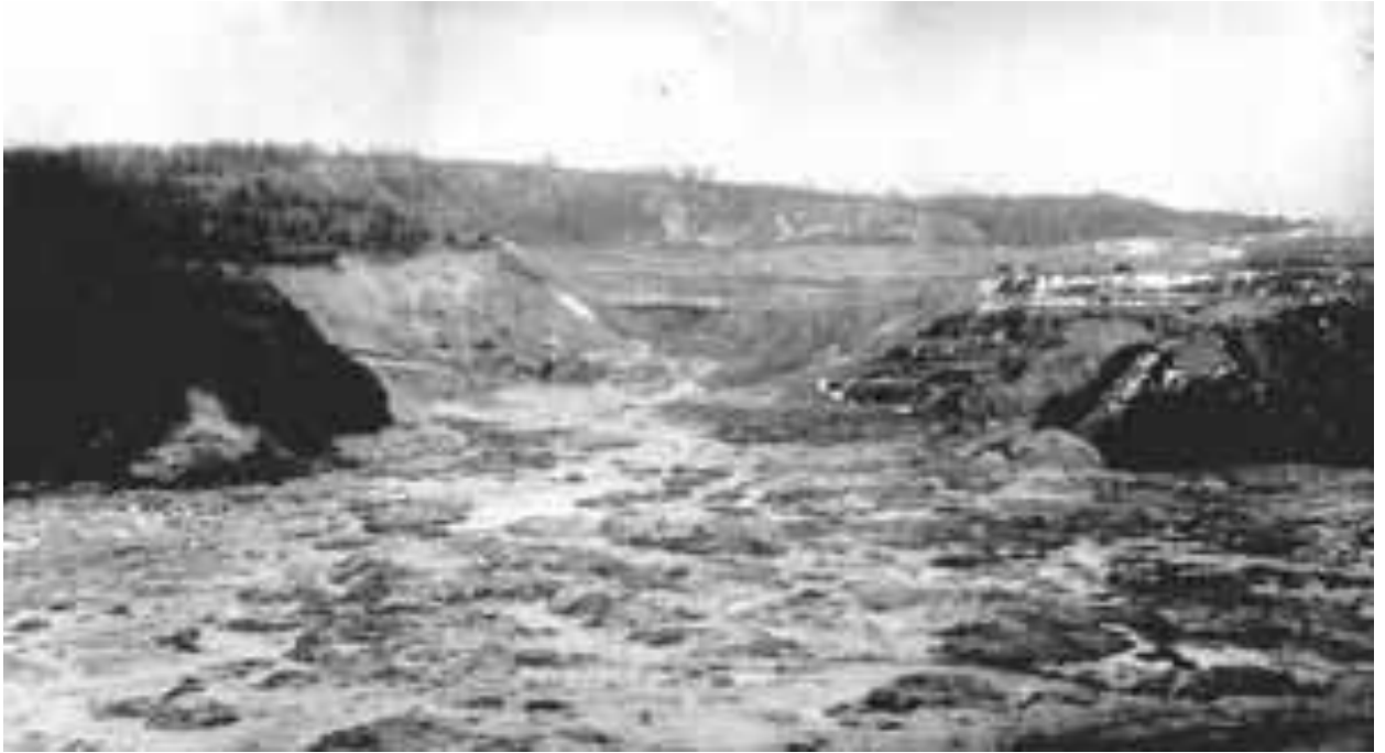
Вид на зруйнований гідровідвалу в відрозу № 3 з боку міста. Справа видно уціліла частина дамби № 1, зліва завалена частину правого берега. На передньому плані залишки ґрунтової маси, що витекла за межі гідровідвалу. (Альбом фотодокументів по аварії гідровідвалу в відрозу № 3 Бабиного Яру в м Києві 13 березня 1961 року. Мал. 9 // ЦДАГОУ, ф. 1, оп. 24, спр. 5364, арк. 6.)
