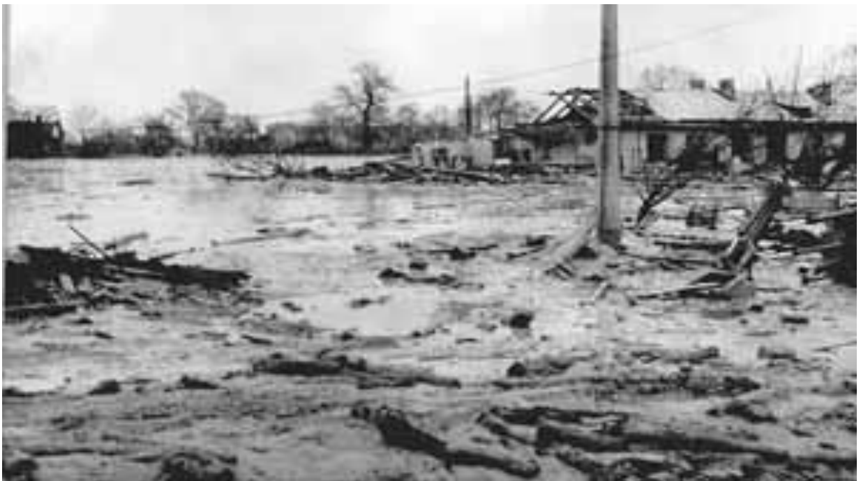
Вулиця Фрунзе з боку міста, залита розрідженого масою ґрунту. вид направо . Вулиця Фрунзе з боку міста, залита розрідженого масою ґрунту. Вид направо. (Альбом фотодокументів по аварії гідровідвалу в відрозу № 3 Бабиного Яру в м Києві 13 березня 1961 року. Мал. 25 // ЦДАГОУ, ф. 1, оп. 24, спр. 5364, арк. 14.)
