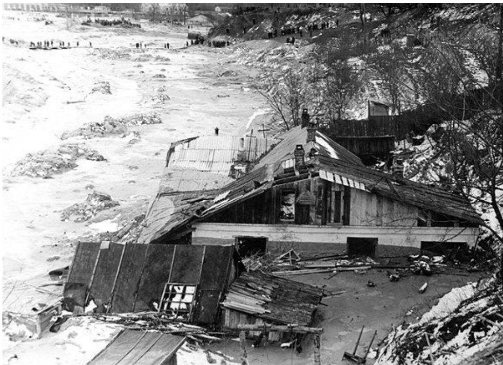
Ділянка Бабиного Яру після аварії. Справа – будинок, що був затоплений грязьовим потоком. Київ, березень 1961 р. Зруйновані будинки та дитячий садок. Джерело: ЦДКФФА України ім. Г.С.Пшеничного, од. обл. 0-232400.
