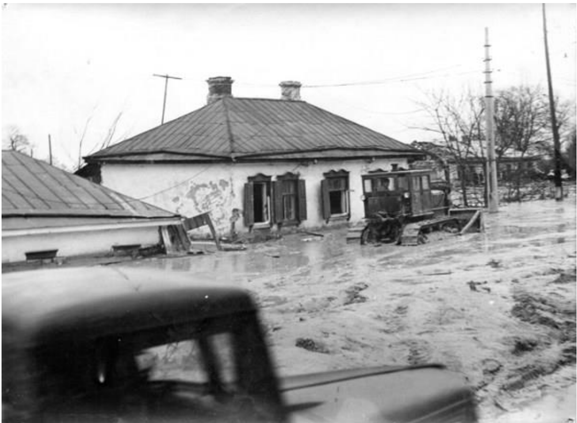
Затоплені будинки по вулиці Фрунзе. Вид вулиці Фрунзе зі сторони міста, що залита після аварії грязьовим потоком. Київ, березень 1961 р. (Джерело: ЦДКФФА України ім. Г.С. Пшеничного, од. обл. 0-232404)
