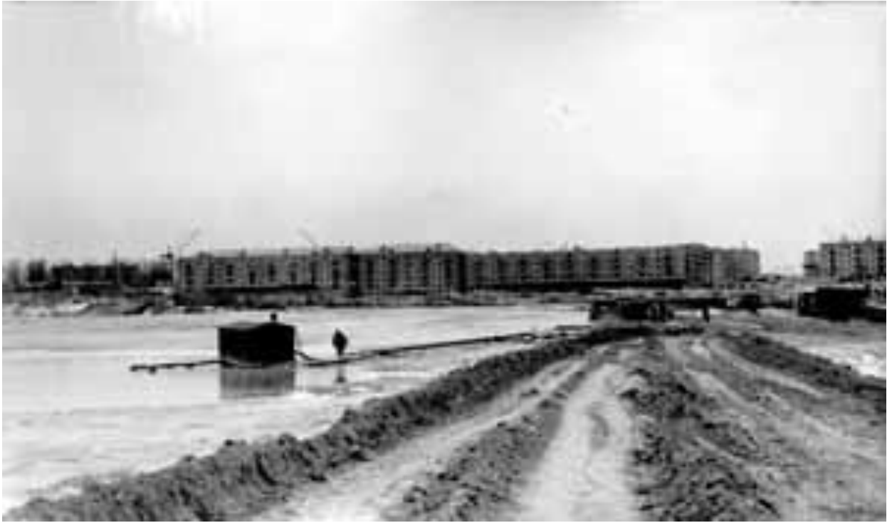
Карта наміву № 4 на ділянці № 3, де проводився намів. Зліва видно насосна станція для перекачки освітленої води Джерело: Альбом фотодокументів по аварії гідровідвалу в відрозу № 3 Бабиного Яру в м Києві 13 березня 1961 року. Мал. 2 // ЦДАГОУ, ф. 1, оп. 24, спр. 5364, арк. 2зв.
